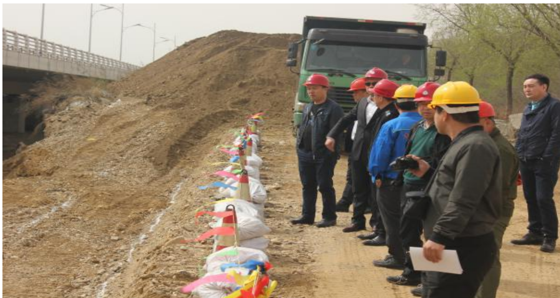
（图为相关领导对施工现场进行安全检查及汇报）
