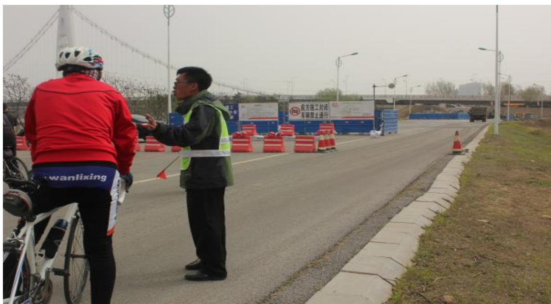
（图为专职安全员现场指挥，保障施工现场及行车、行人安全）
